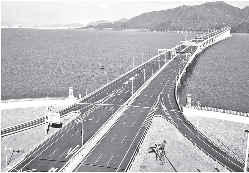
港珠澳大橋人工島
