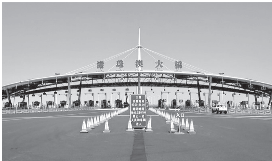
港珠澳大橋入口處
