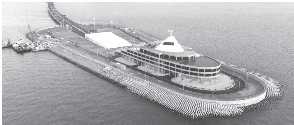
港珠澳大橋人工島
